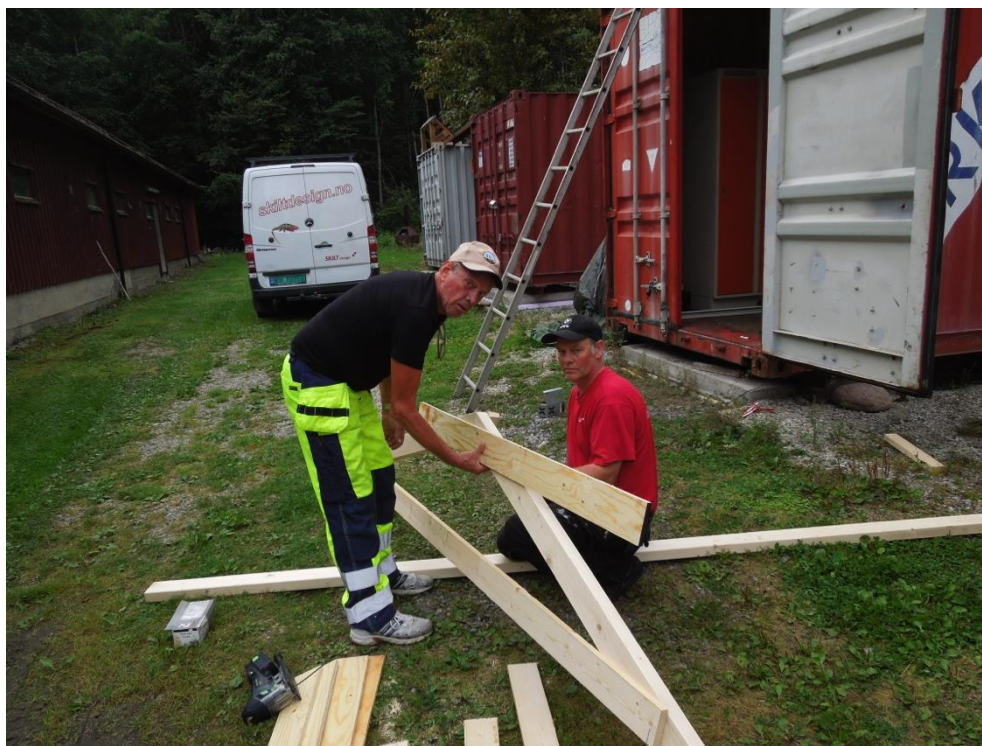
Figur 18 Finn Ivar Møller og Hans Olav Sørumengen lager mønetak på containeren.
