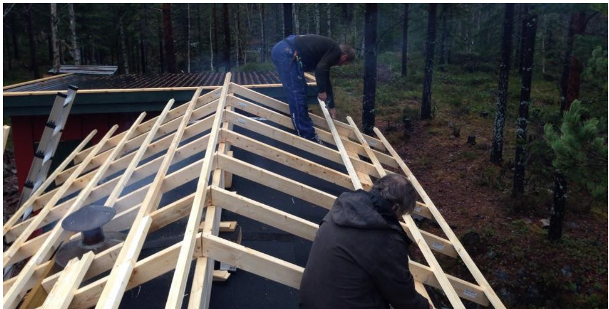
Bilde 19 Det legges nytt tak på Sandungsbrakka.
