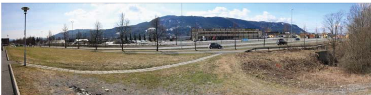
Sammensatt panorama fra kulvertinnløp og nedover langs Rosenkrantzgata. Vi ser den store høydeforskjellen mellom kulvert der bekken går inn (til høyre i bildet) og eksisterende terreng langs Rosenkrantzgata. Foto: Sweco Norge AS
