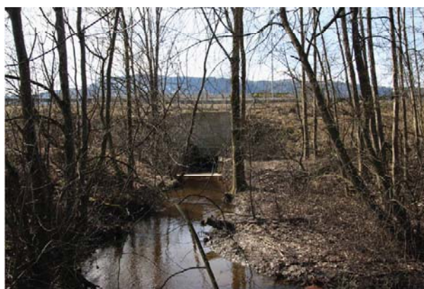
Inn mot kulverten under Rosenkrantzgata. Høydeforskjellen er ca 5 m mellom veien og bekkebunnen. Foto: Sweco Norge AS
