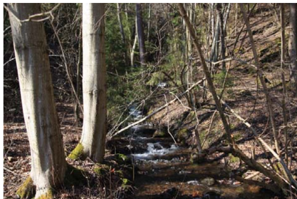
Landfallbekken i sitt naturlige løp like før innløp i kulvert.
