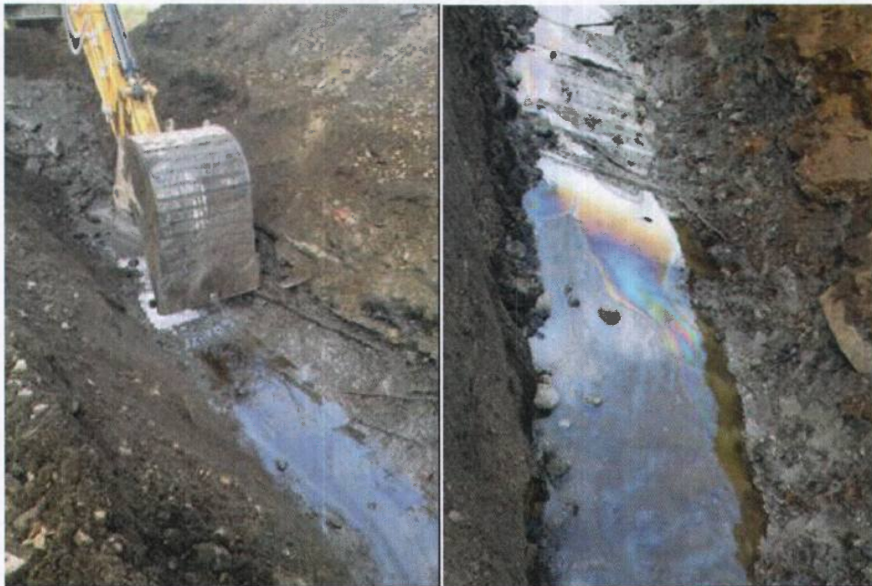
Figur 5, Foto av innstrømmende olje og kreosot i drengrofter
