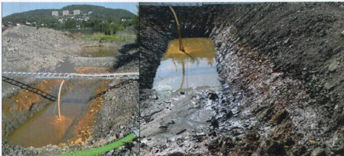
Figur 6, Pumping av drengrofter 2009
