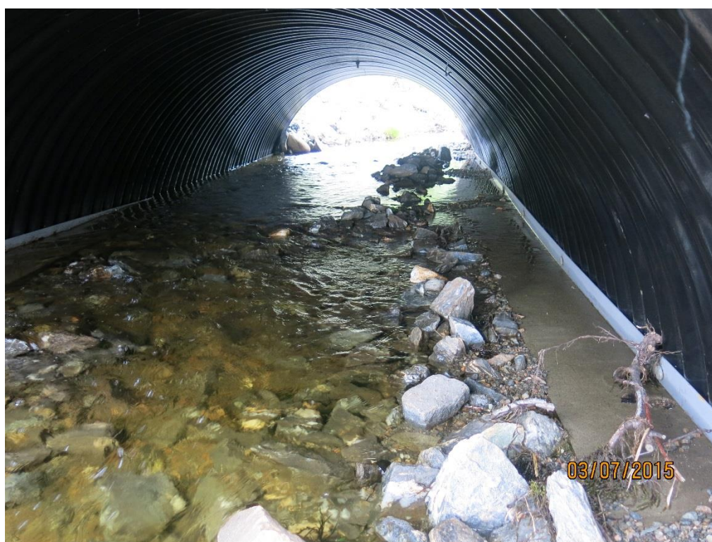
Fig. 71. Hvelvkulverten har naturlig elvebunn og gode vandringsforhold for fisk (Foto: Lars Aage Gade-Sørensen).
