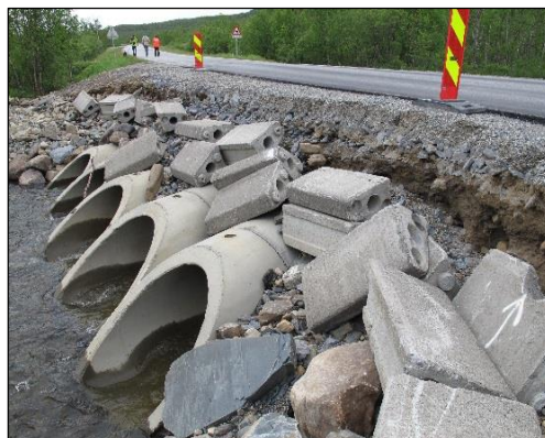
Fig. 23. Underdimensjonert hydraulisk kapasitet på kulvertene kan resultere i store skader på vegkroppen ved innløpet til kulvertene (Foto: Øyvind Haugland).
