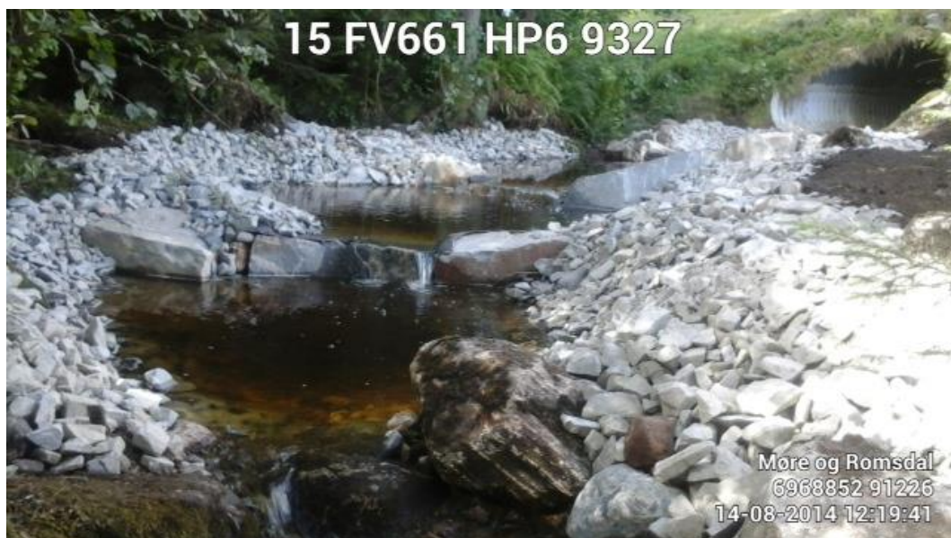
Fig. 50. Tre terskler er anlagt nedstrøms kulvertutløpet i Stokkelandsløken. Vannspeilet står inn i kulverten. Sprengstein er brukt som erosjonsikring langs sidene (Foto: Statens vegvesen Region midt).
