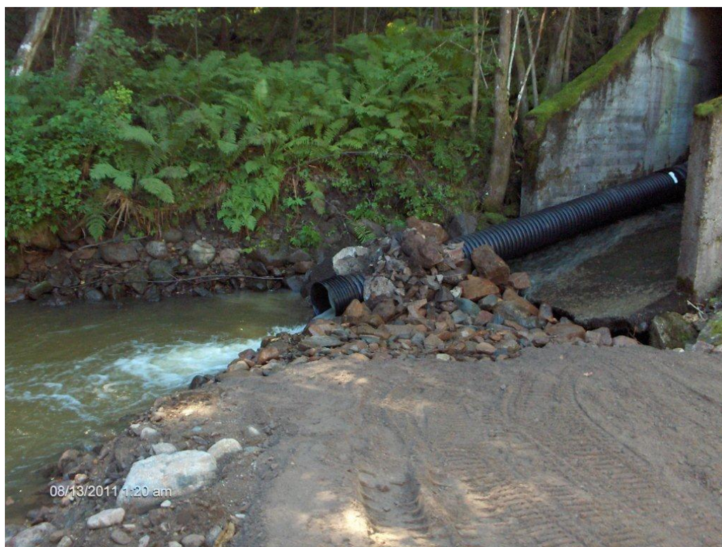
Fig. 33. Bekken ble ledet gjennom rør under hele byggeprosessen (Foto: Torleiv Inge Kili).
