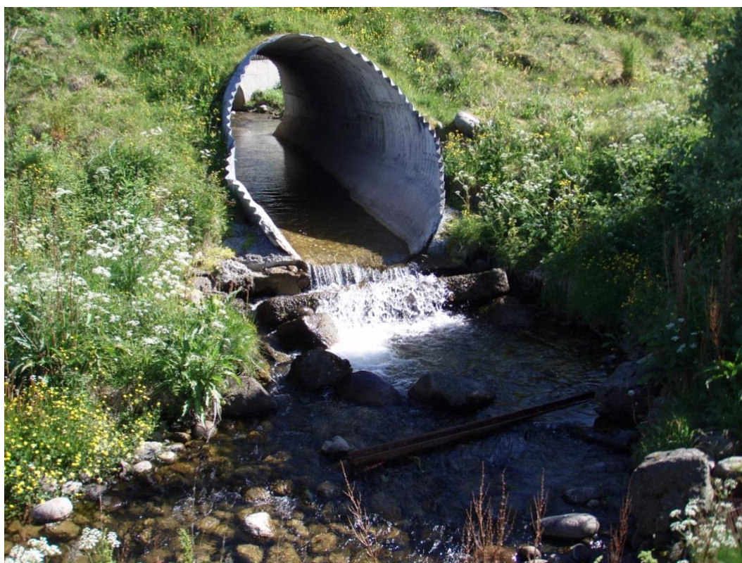
Fig. 67. Høyt sprang ved utløpet av kulverten i Nykvågvasdraget (Foto: Knut Aune Hoseth).
