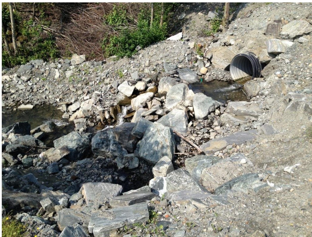
Fig. 53. Terskel med fiskerenne nedstrøms kulvertutløpet i Follobekken (Foto: Anton Rikstad).
