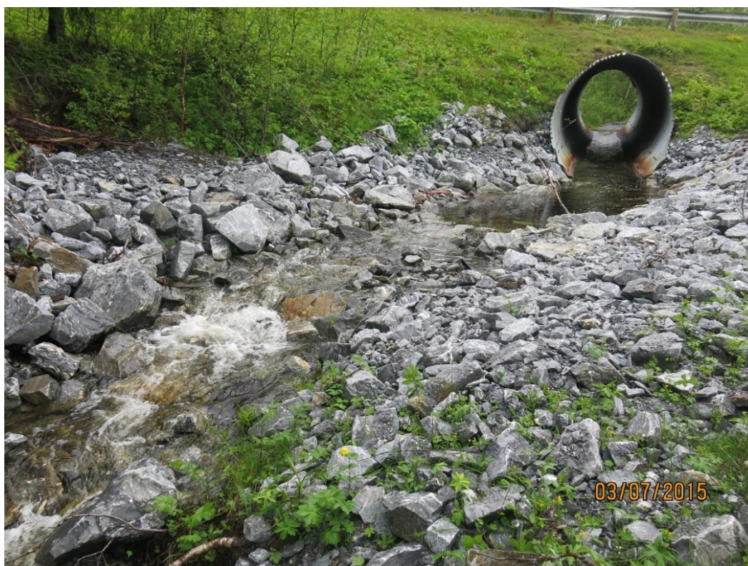
Fig. 2. Nedstrøms kulvertutløpet er det anlagt en terskel med en fiskerenne opp til terskelbassenget (Foto: Lars Aage Gade-Sørensen, Statens vegvesen Region nord)
