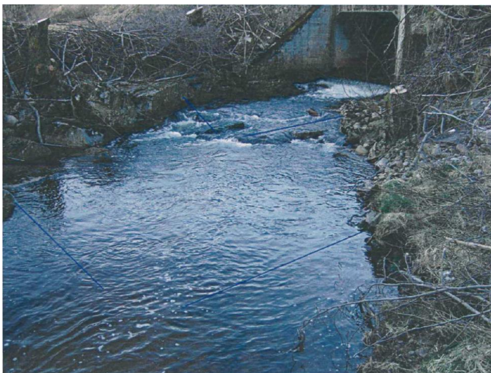
Fig. 44. Kulverten og kulpen nedstrøms kulvertutløpet i Breibekk (Foto: Alf Magne Midtbø Versland).
