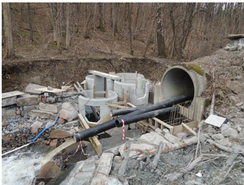
Fig. 40. Anleggsområdet ved utløpet av kulverten. Flere rør brukes for å lede vannet i bekken gjennom anleggsperioden (Foto: Paul Ridola).
