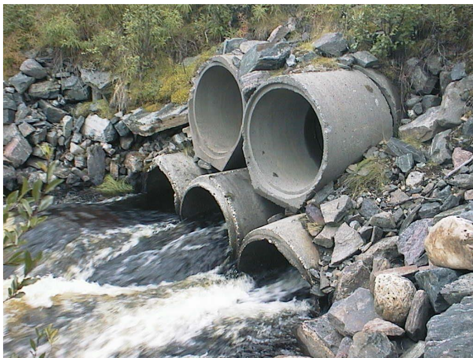
Fig. 79. Fem kulverter ved utløpet av Savkadasjohka (Foto: Knut Aune Hoseeth)
