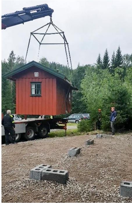
Flytting av Sandungsbrakka Foto: Tor Andreassen
