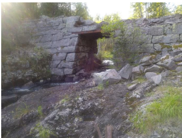
Nedre demning Rotua-Grunnvannet
