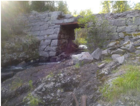
Nedre demning Rotua-Grunnvannet
