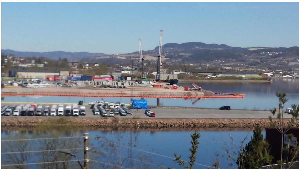
Utfyllingen ved Holmen pågår kontinuerlig med store lastebiler. Foto: Borgar Pedersen
