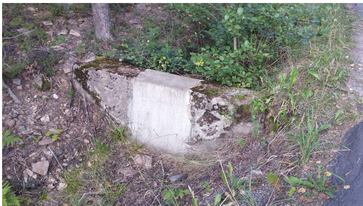
Betongmur i opprinnelig utløpsbekk ved Landfalltjern. Foto: Borgar Pedersen
