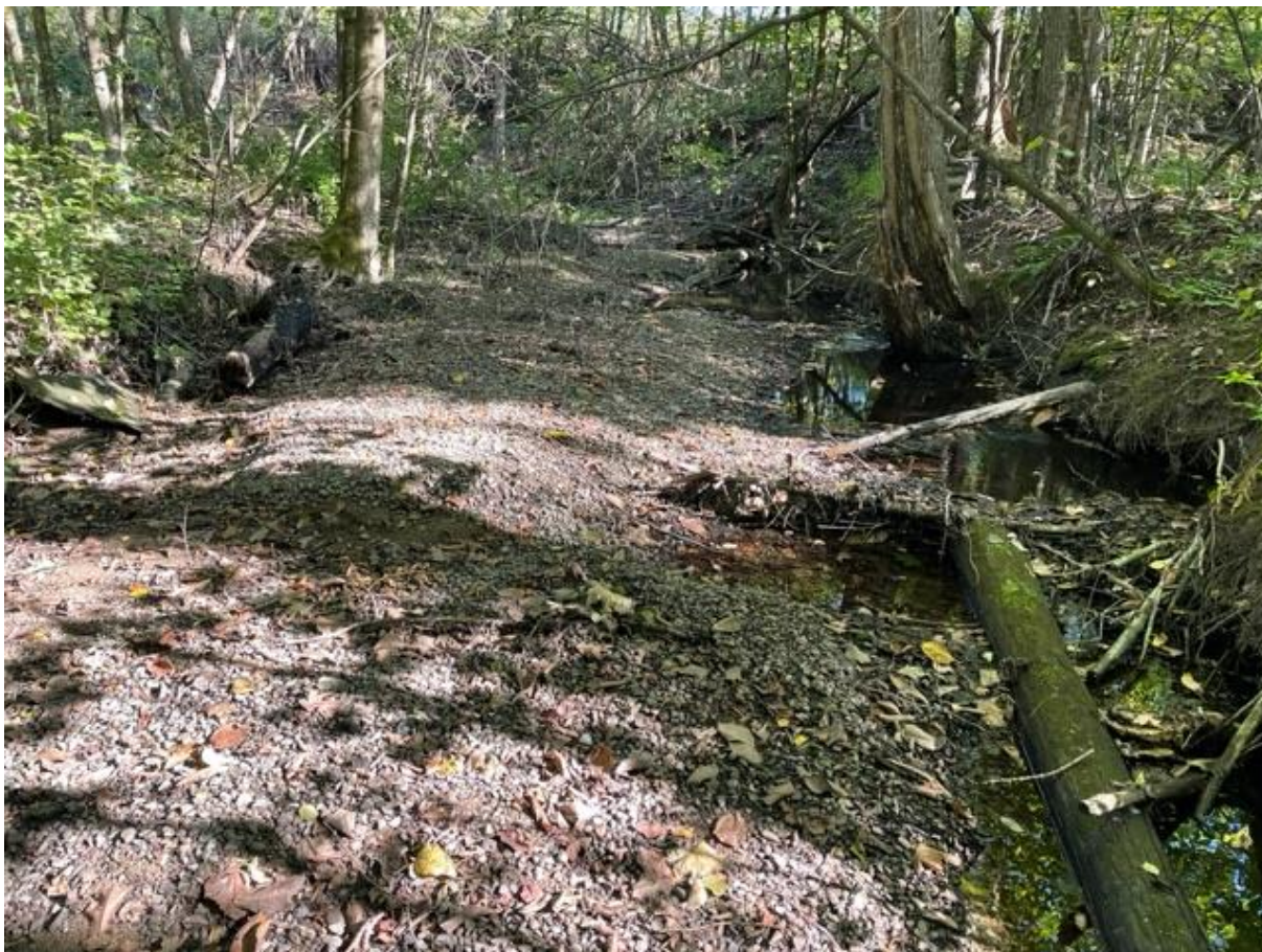
En del av bekkens meanderløp er fylt opp med pukk. Foto: Borgar Pedersen
