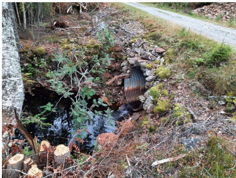
Langvannsbekken: Røret under veien kan være et vandringshinder for ørreten. (Foto: Jan I. Larsen)
