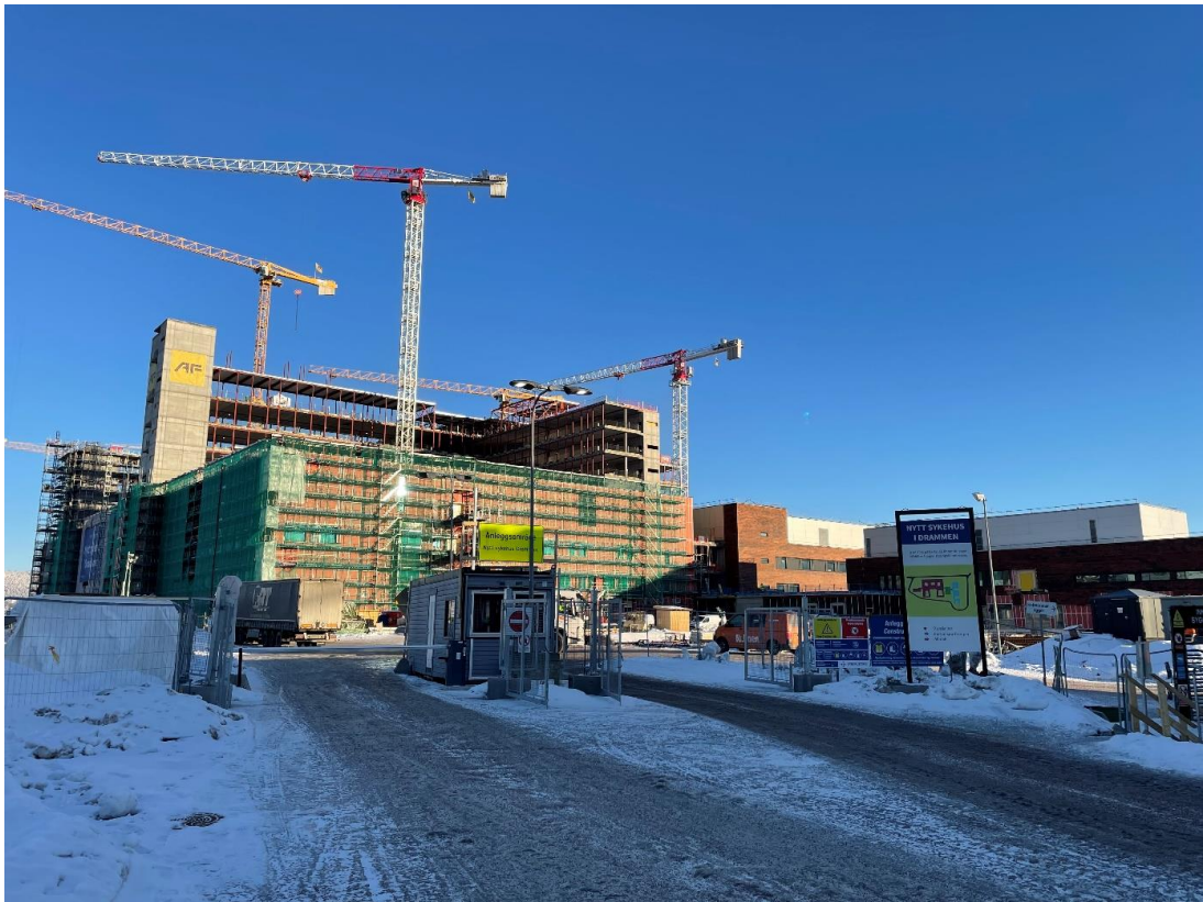
Bygging av nytt sykehus Foto: Borgar Pedersen
