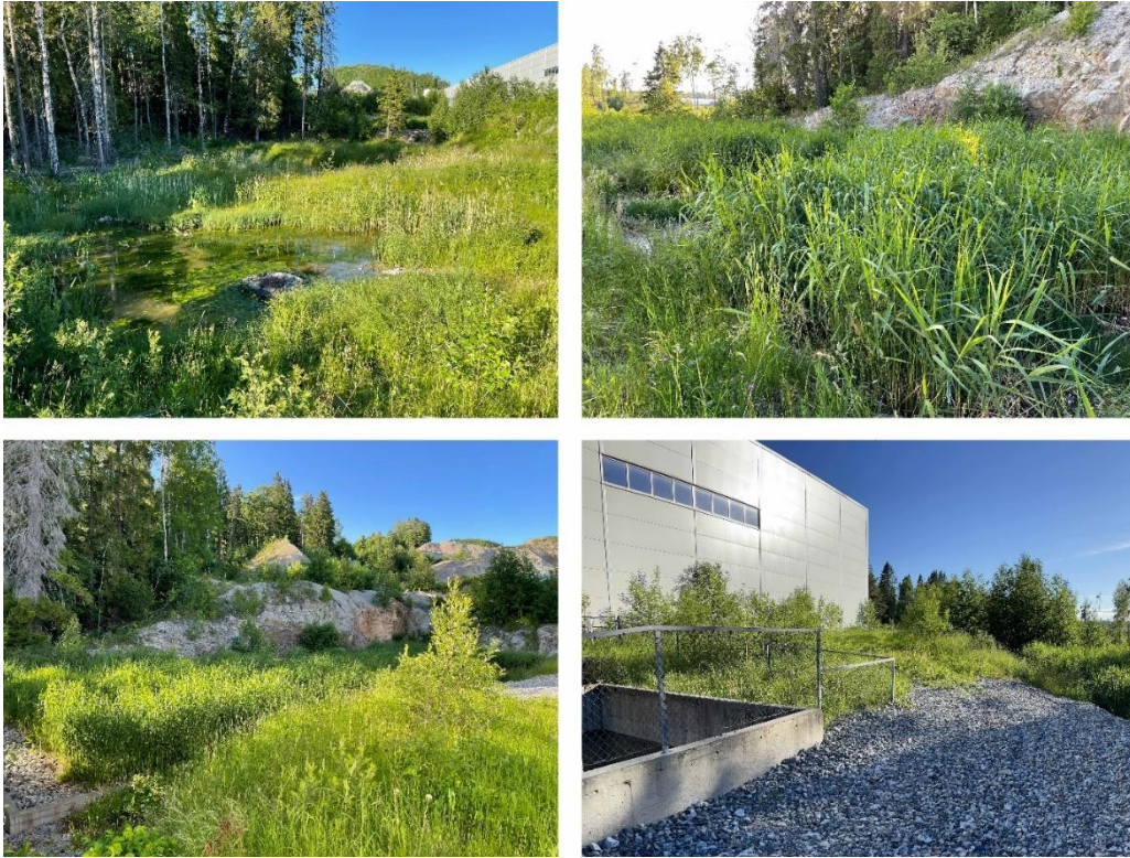
Biologisk renseanlegg ved Gjellebekk Foto: Borgar Pedersen
