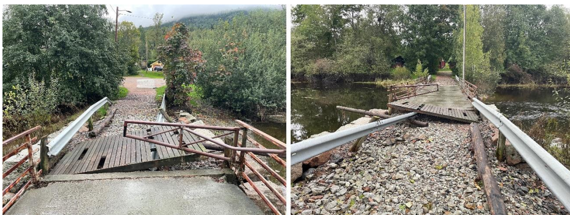
Broa til Søfastøya ble delvis ødelagt av flom forårsaket av stormen Hans. Foto: Borgar Pedersen
