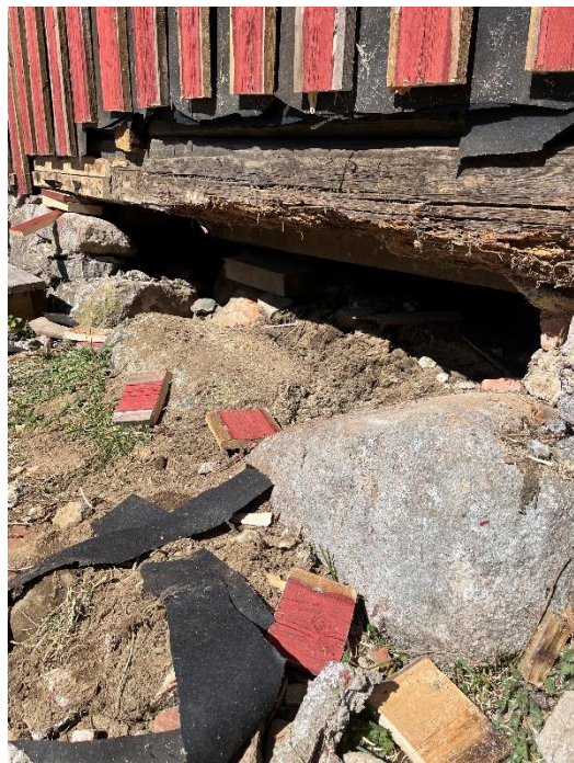
På den ene bunnstokken ble det oppdaget råte og tidligere angrep av trespisende skadedyr. Dette ble omhyggelig skiftet ut og steinmur ble demontert og satt tilbake i samme stand.
