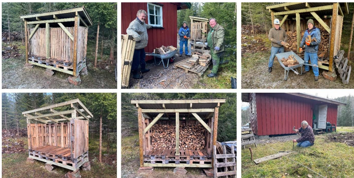
Bygging av vedskjul Foto: Borgar Pedersen med flere
