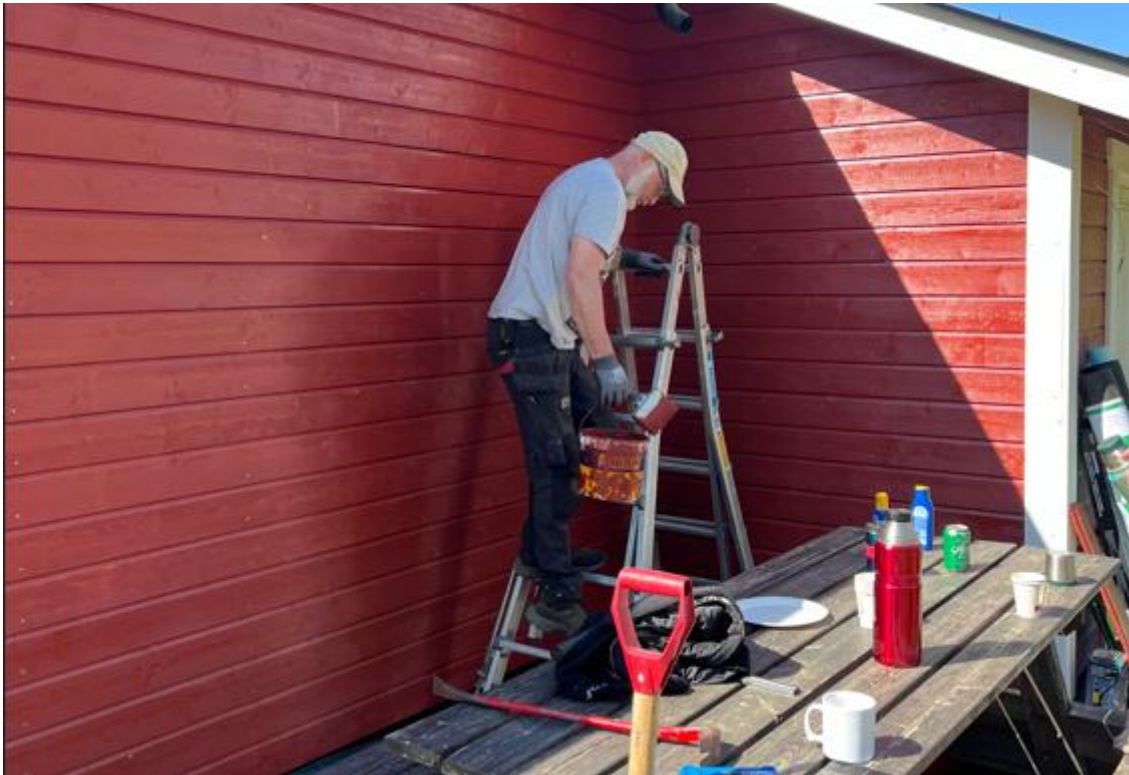
Den nye kledningen fikk ett strøk med maling før den ble montert på veggene. Så fikk den det siste strøket når den satt på veggen.
