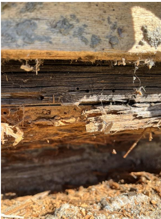
På den ene bunnstokken ble det oppdaget råte og tidligere angrep av trespisende skadedyr. Dette ble omhyggelig skiftet ut og steinmur ble demontert og satt tilbake i samme stand.
